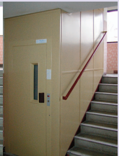
Výtah po rekonstrukci
